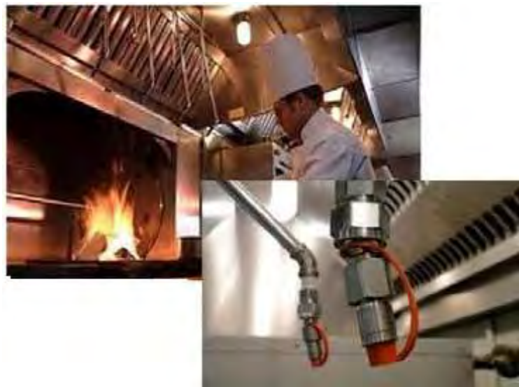
Sistema Anti Incendio
